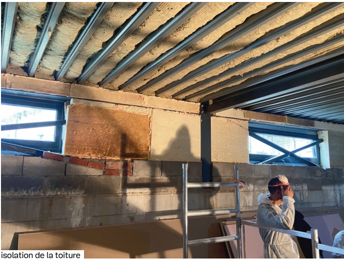
isolation de la toiture
