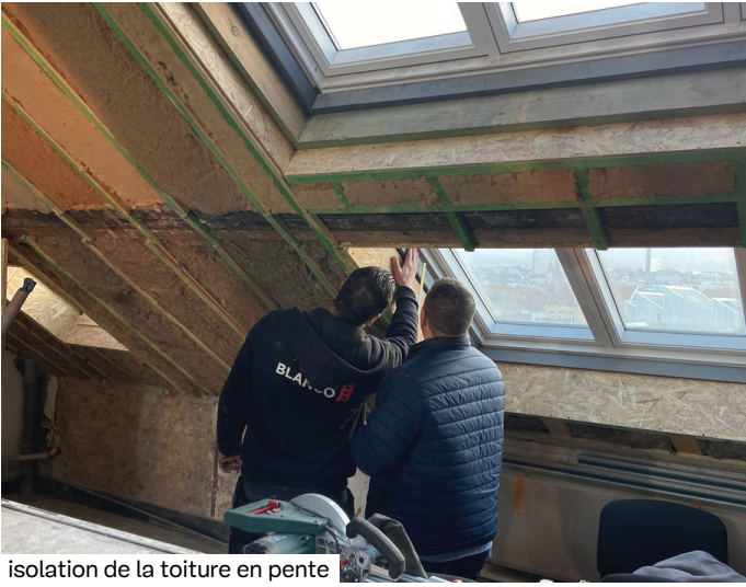
isolation de la toiture en pente
