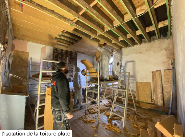
l'isolation de la toiture plate
